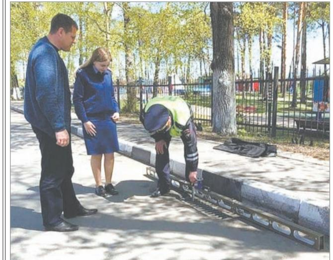
Установлено, что в нарушение законодательства система ливневой канализации по пер. Парковый и ул. Садовой, Кирова не очищена от грязи. По этой причине после проливных дождей система ливневой канализации не справляется с объемом воды, и улицы города подтопляются.
